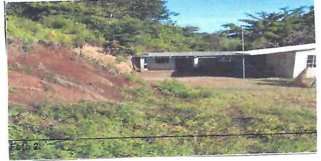
Foto 2: lado izquierdo propenso a derrumbes
